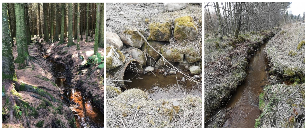
Figur 7. Kalbergbekken renner gjennom Kalbergskogen (t.v.) og langs Kalbergveien. Bekken er delvis grøftet, steinsatt og kanalisert, og med enkelte rørlagte strekninger. Bunnforholdene er noe tilslammet. Bekkens betydning for ørret er ukjent.
